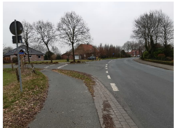
Abb. 6.: Einmündung von Osten
